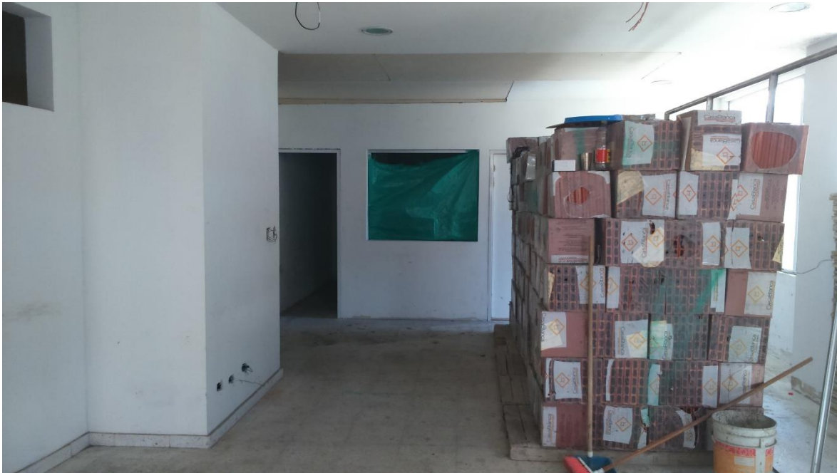
Fotografía 2. Material en obra correspondiente al contrato No. 1697 de 2011
